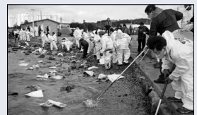
흡착포를 이용한 기름 제거 작업
